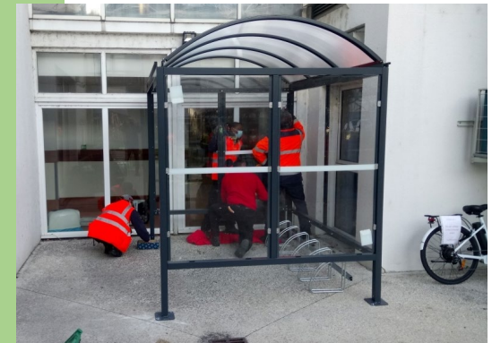
Installation d'un abri-vélos à La Vallée du Cher
