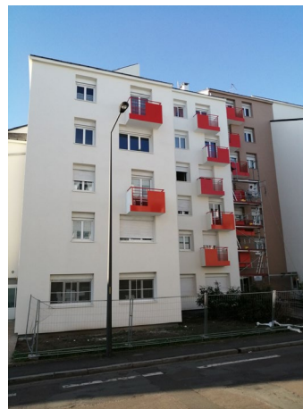
Une façade rénovée à St Paul
