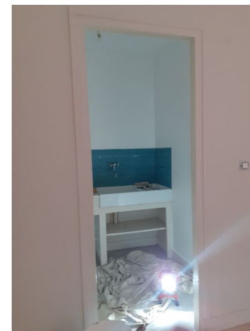
Rénovation en régie d'une pièce d'eau Résidence Arche des Noyers
