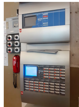
Changement du Système de sécurité incendie à l'EHPAD Vallée du Cher
